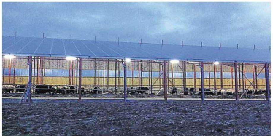
Le toit du nouveau bâtiment est recouvert de 996 panneaux photovoltaïques.
