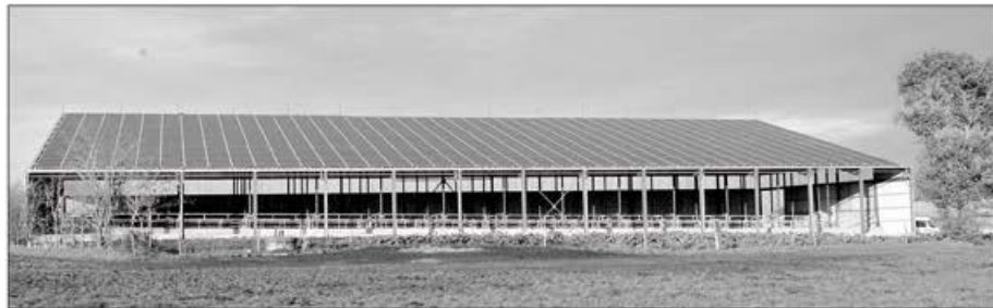
Installation de 249 kWc sur un bâtiment agricole à Saint-Etienne de Mer Morte.
