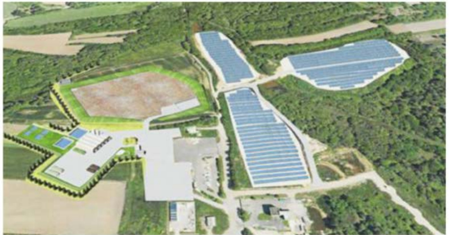
La CCPC voudrait implanter une centrale solaire au sol sur le site de l'ancienne décharge de Kerdanvez.
