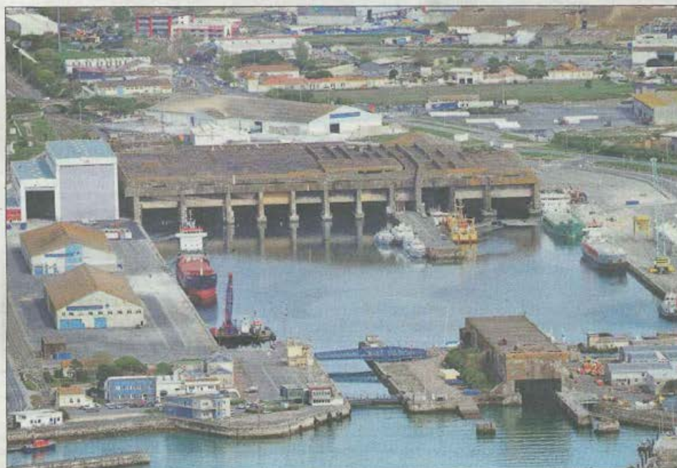
2,2 hectares de toitures de hangars et 2,4 hectares de toiture de la base sous-marine seront équipés de panneaux photovoltaïques. PHOTO XAVIER LÉOTY
