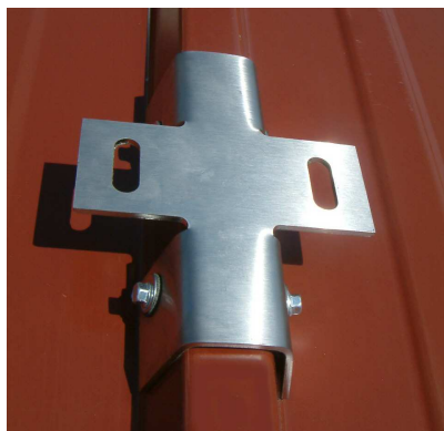
Le collier de serrage est fixé
