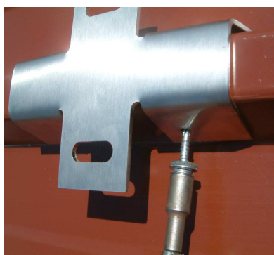
2ème pas Visser avec des vis auto perçantes
